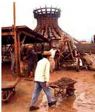
Construção de Brasília, autor e data desconhecidos.
